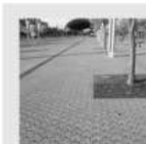
Sono marciapiedi o parcheggi che permettono alla pioggia di infiltrarsi attraverso la superficie pavimentata in uno strato di raccolta inferiore, dove l'acqua è contenuta prima di essere infiltrata nel terreno, riutilizzata, o rilasciata ad altri dispositivi drenanti.
